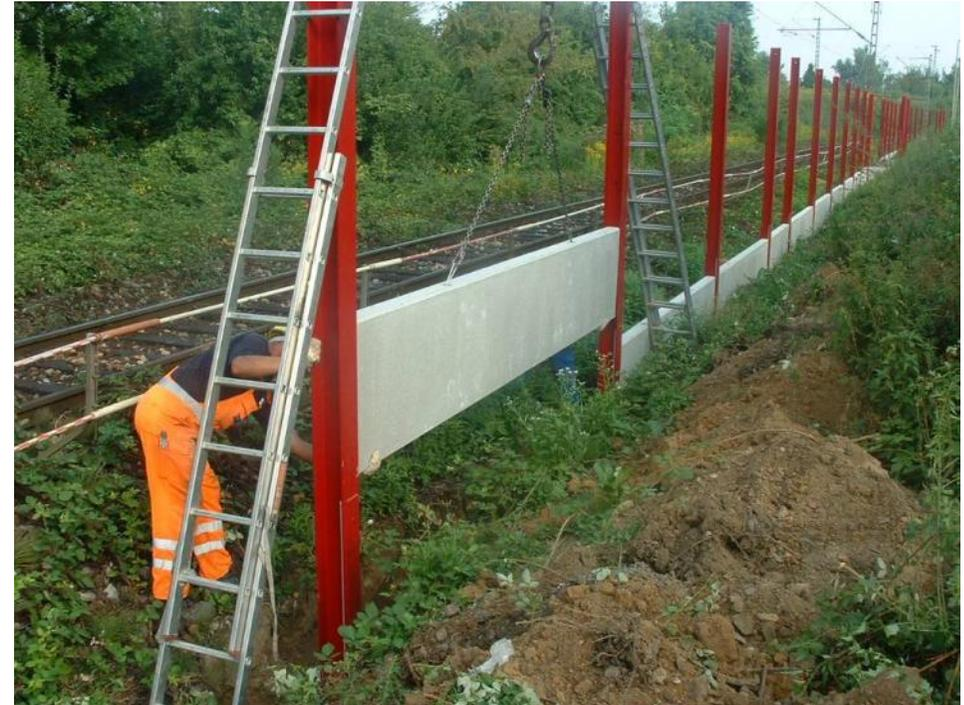
Nach dem Aushärten des Betons werden die Sockelelemente eingebaut
