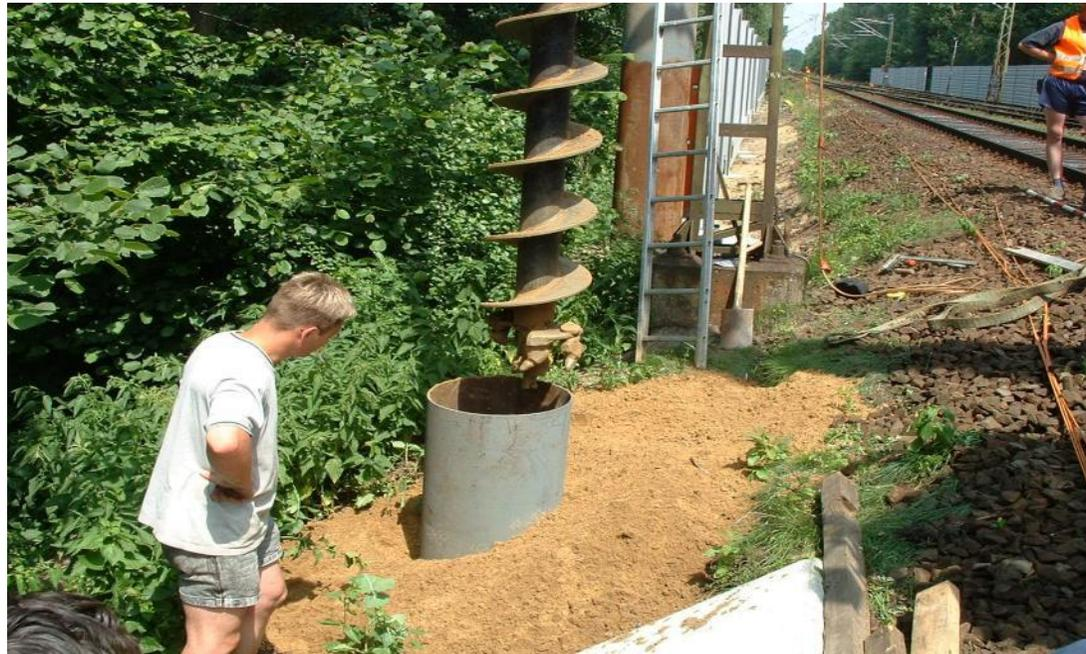
Nach dem Einbringen der Rohre werden diese entkernt.
