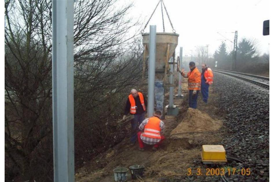
In einem weiteren Arbeitsschritt werden die Pfosten vergossen.
