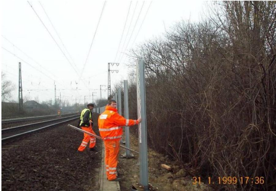
Jetzt werden die Pfosten der Lärmschutzwand aufgestellt und in den Rohren fixiert.
