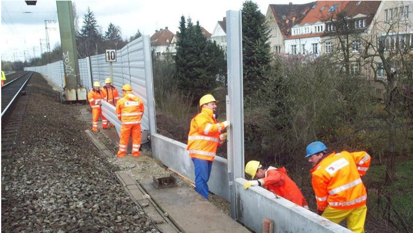
Abschließend werden die Schallschutzelemente eingebaut.
